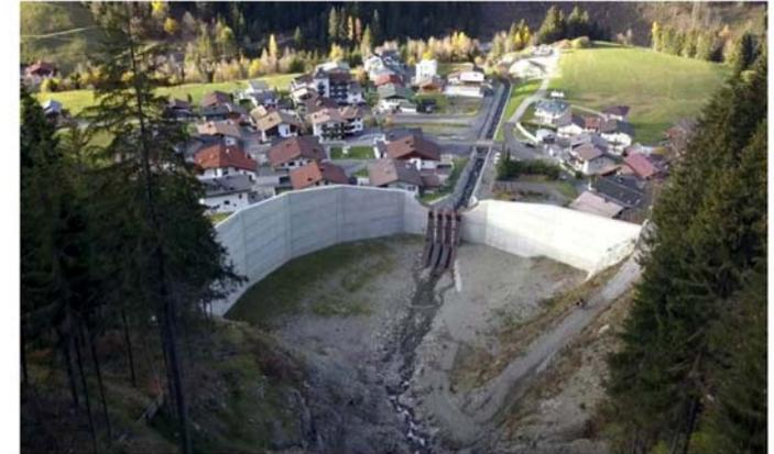
**Figura 13 Barreras para flujos de lodos y escombros**
