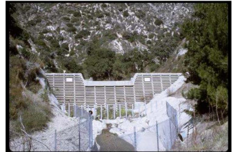
**Figura 12 Presas cerrada con alcantarilla de fondo para flujo base**
