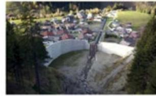
Figura 12 Barreras para flujos de lahar y cenizas
