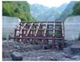
Figura 11 Presas abiertas para reducir la intensidad de un flujo de lahar
