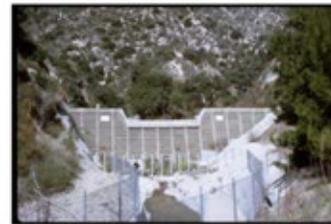
Figura 13 Presas cercadas con alambrado de fondo para flujo base
