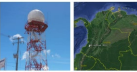
Figura 2. Radar meteorológico de Cerro Munchique. A la izquierda foto del instrumento en sitio, a la derecha cobertura técnica del radar con un radio de 240 Km.
